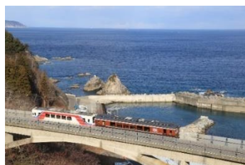
大沢橋梁(岩手県普代村)
