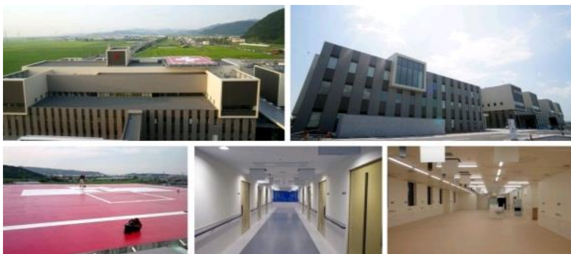
写真 完成した病院の外観・内観
