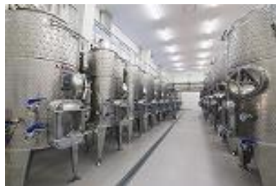
製造タンク室
