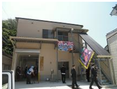
写真2 完成した新しい加工場
