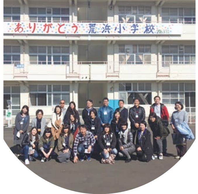
JALグループ社員対象の「東北復興応援研修」で被災した震災遺構仙台市立荒浜小学校を訪問
