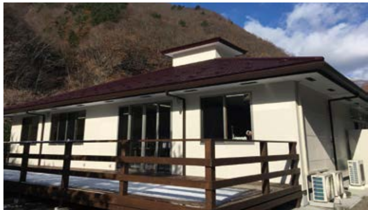
障害者を対象にした就労支援センター（釜石市）
