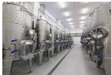
製造タンク室
