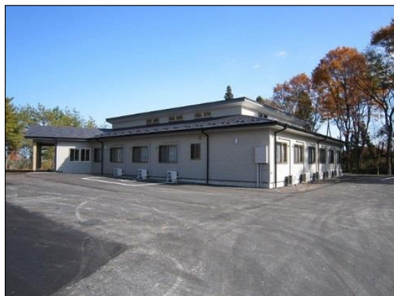
写真1 介護施設の全景
