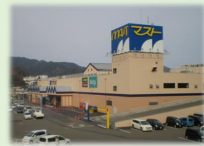
復旧後の外観
