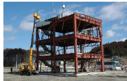
南三陸町防災対策庁舎
