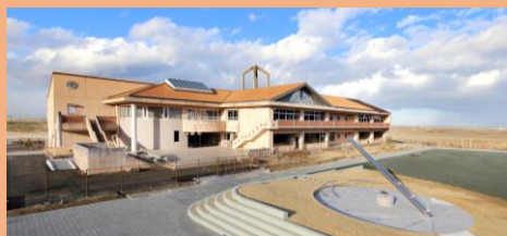
山元町震災遺構中浜小学校
