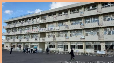
震災遺構仙台市立荒浜小学校
