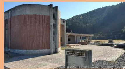
石巻市震災遺構大川小学校
