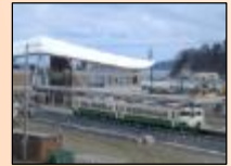
運行が再開された石巻線 (女川駅)
