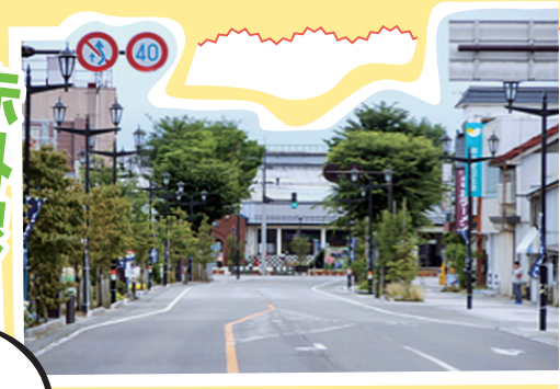
道路や公園などを整備するための設計を行っています
