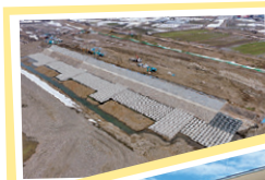
豪雨災害などで被害を受けた護岸の復旧工事も行っています
