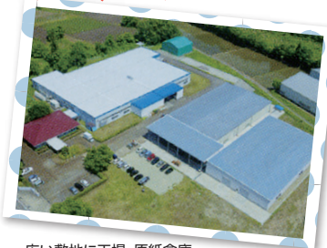
広い敷地に工場、原紙倉庫、製品倉庫が並んでいます
