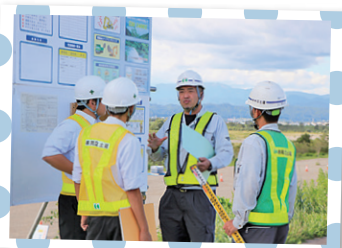
会津坂下町での護岸災害復旧工事の現場。台風によって崩れた護岸を修復しています
