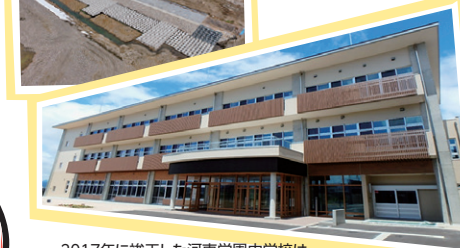
2017年に竣工した河東学園中学校は、会津若松市優良建設工事として表彰されました
