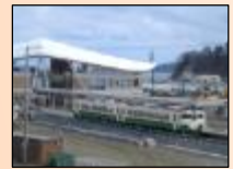
運行が再開された石巻線 (女川駅)
