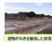
建物がけがきを撤去した状況 (11月24日)
