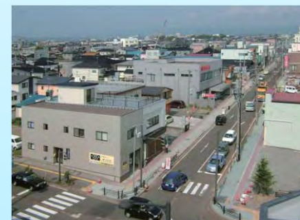
復旧後のえんま通り(新潟県柏崎市)
