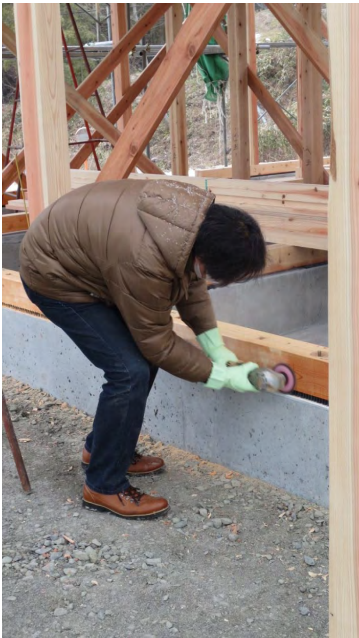
ピレスロイド系シロアリ駆除剤 の撤去。
